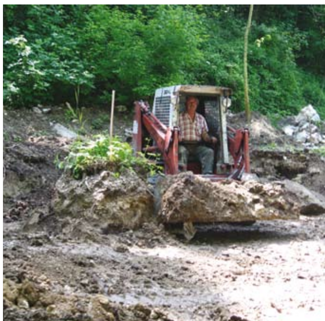
Földmunkák a keresztút építésénél
